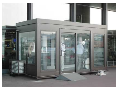
喫煙所 成田国際空港 千葉県成田市
