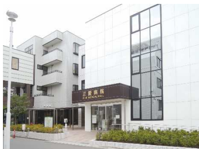
病院手術室 三愛病院 埼玉県さいたま市
