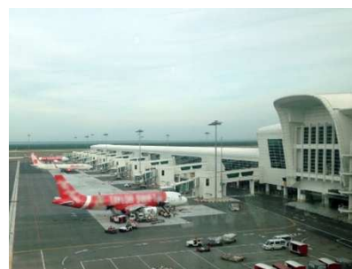
空調室 クアラルンプール国際空港 マレーシア
